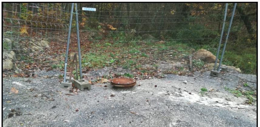
Vue du forage AF2 où sera posé le regard de protection
