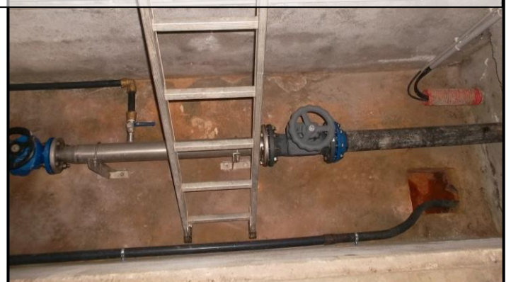
Vue de l'intérieur de la station où arrivera le réseau de refoulement et où seront posés les différents équipements hydrauliques pour le raccordement du forage AF2 : l'arrivée du réseau se fera au droit du compteur existant ( flèche rouge )
