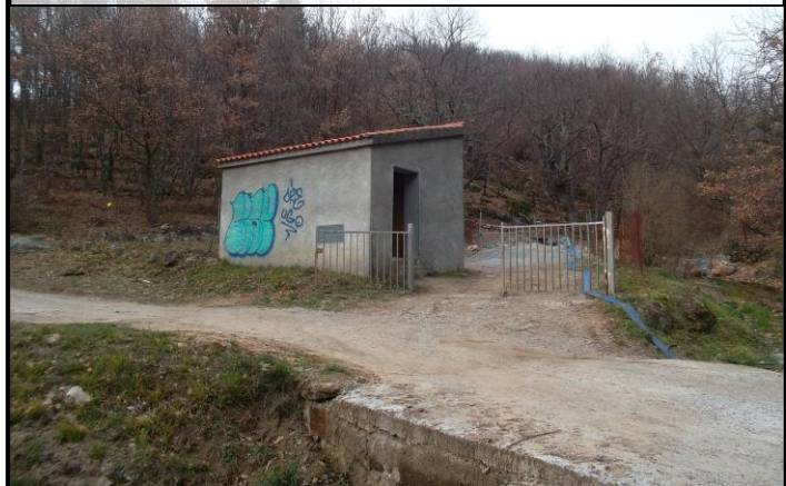
Arrivée devant le site et passage du ruisseau sur le pont : attention ici virage très séré
